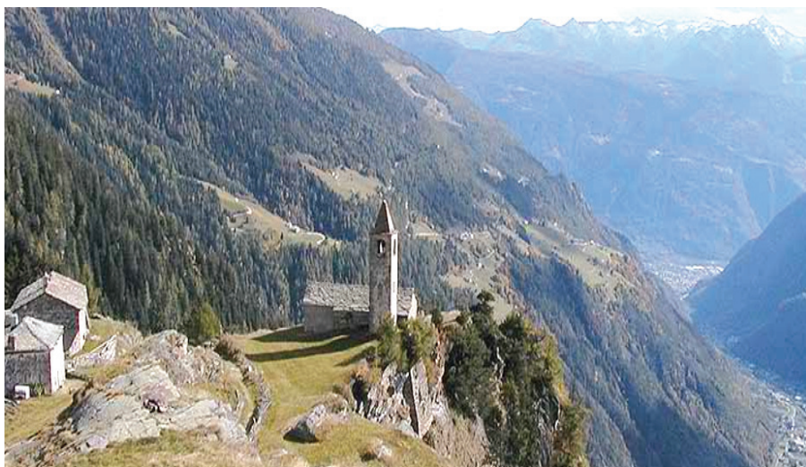
Fig. 22 – San Remigio. Vista da nord verso sud.
